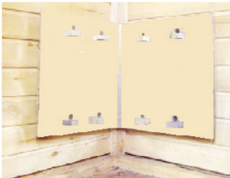
Фото 2. Установка термозащиты
