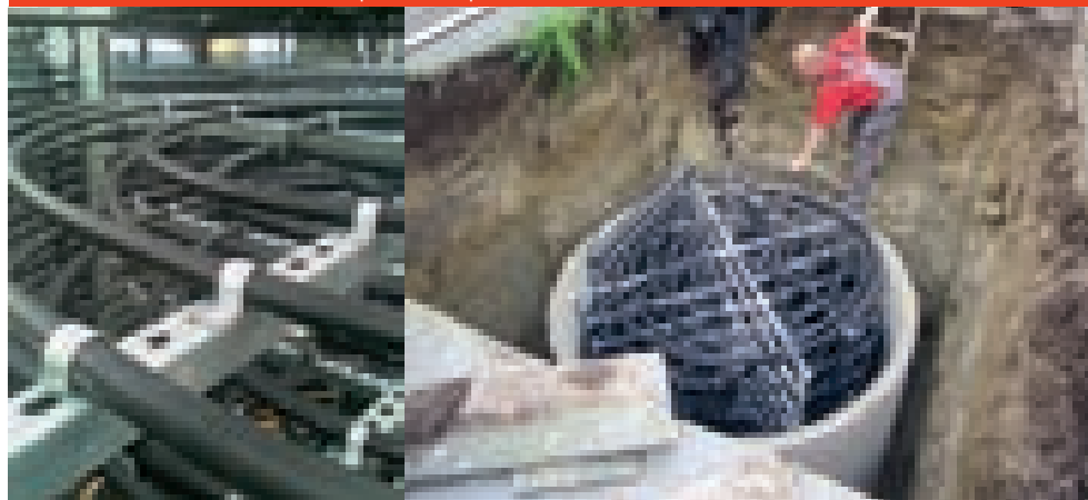
Рис. А.4.7–2 Накопители тепла с фазовым переходом
